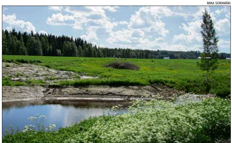
Lammin Koiransuolenojalle rakennetut pohjapatoaltaat hidastavat veden virtausnopeutta.
